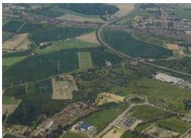
Le pôle Douaisien et l'arc minier : vue aérienne de la ZAC de la Renaissance avec Somain et la gare de triage en arrière plan
